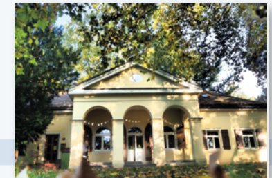
Das 1831 als Friedhofshalle des Lazarusfriedhofs errichtete denkmalgeschützte Gebäude ist sanierungsbedürftig
