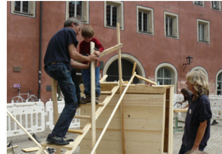
Bei der Bauaktion auf dem Haidplatz 2011 wird die Idee eines Bauspielplatzes sicht- und erlebbar
